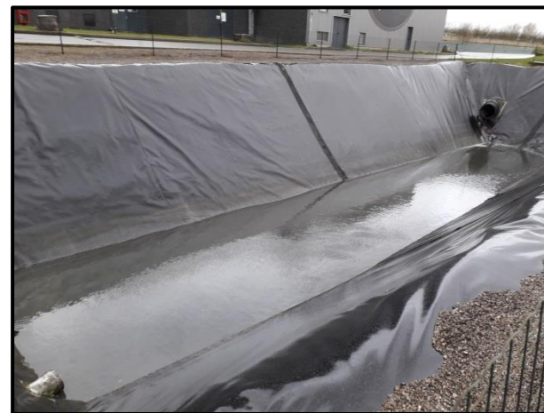
Photo 16 : Bassin de rétention, photo prise sur site (Rainette)
