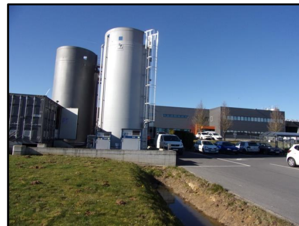
Photo 13: Bâtiment industriel (Rainette, 2019)
